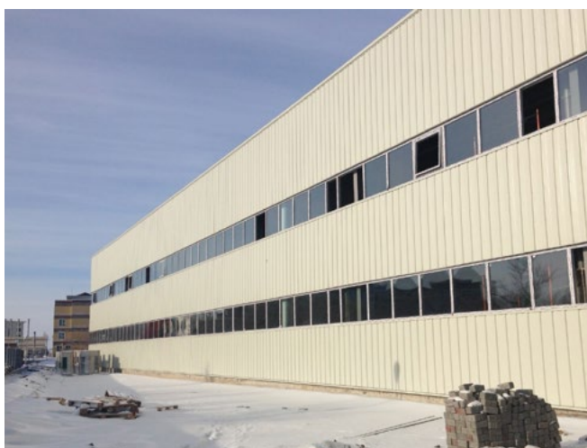
Автосалон Hyundai, Астана (в процессе монтажа)
